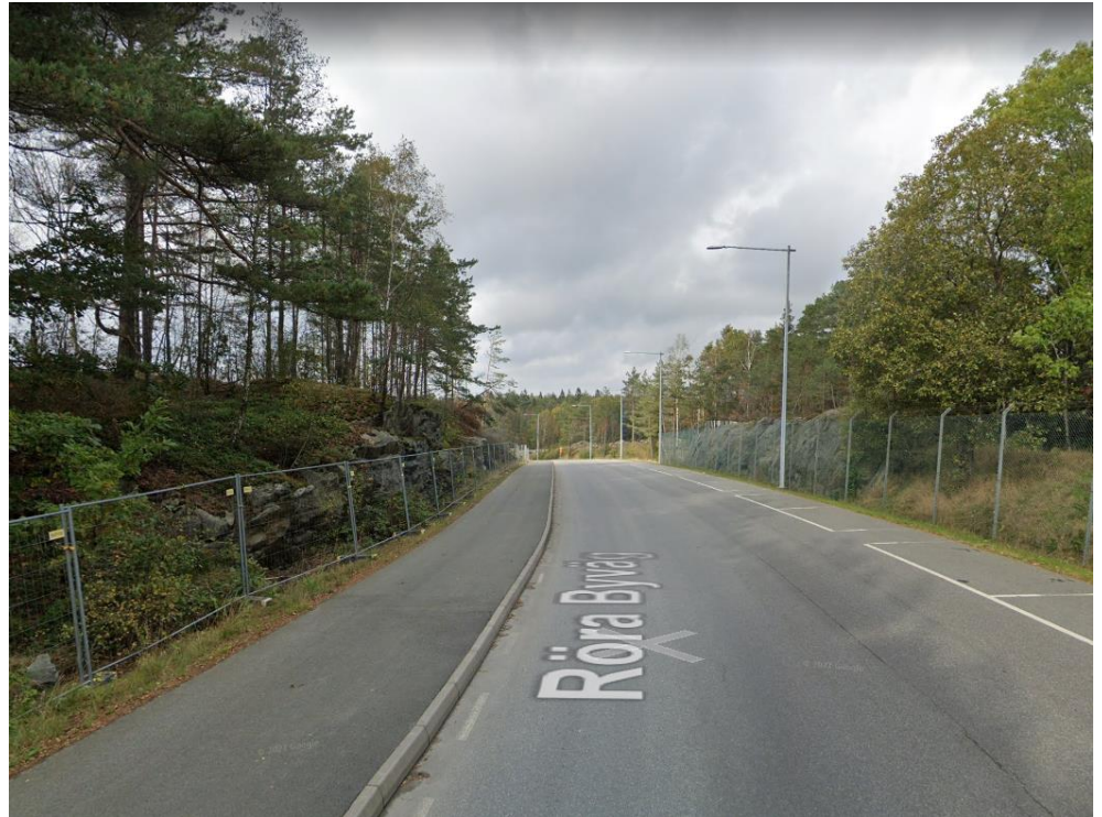
Figur 17 Bergskärningar på vardera sida av Röra Byväg vid detaljplaneområdets nordvästra ände. (Google, 2022-08-19).
