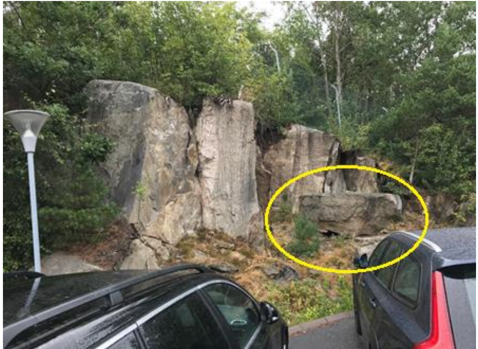
Figur 23 Stort block som lossnat från bergskärningen. Det hela verkar ha skett nyligen. Risken för ytterligare ras bedöms som låg (COWI 2022-08-18).
