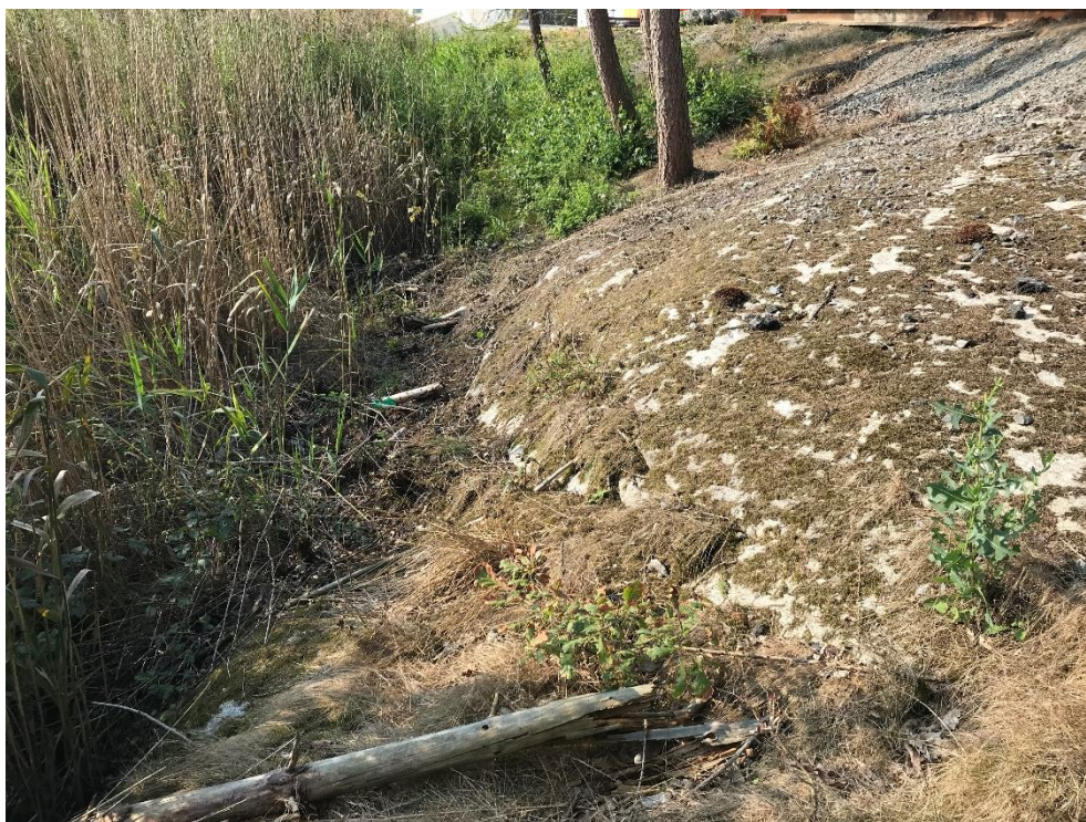
Figur 16 Dammens västra bank, fotad från norr (COWI, 2022-08-19)
