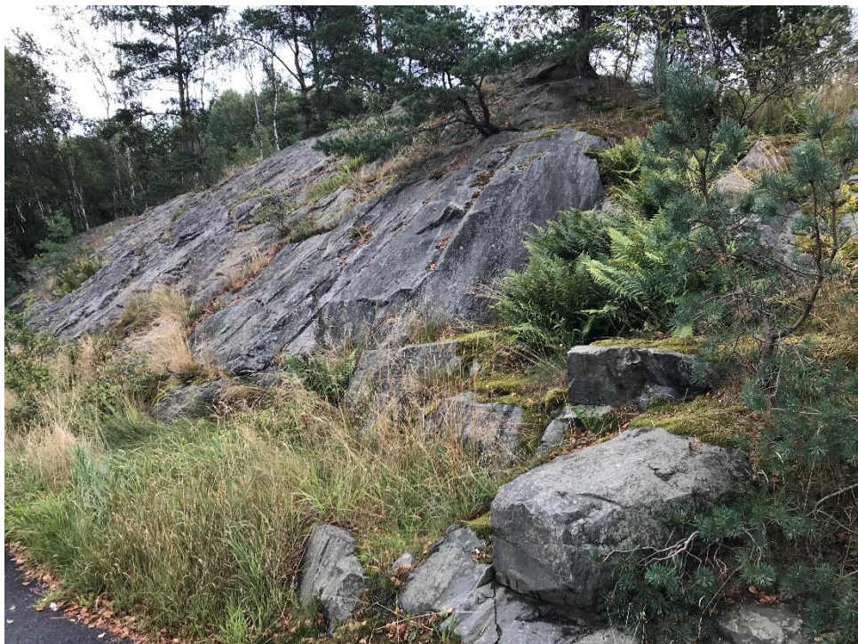
Figur 28 Bergskärning längs Assar Gabrielssons Väg. Berget följer naturliga strukturer och är stabilt (COWI, 2022-08-19).
