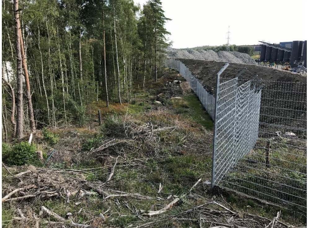
Figur 21 Planområdets nordöstligaste del. Den tidigare höjd som fanns här har ersatts av en täkt (COWI 2022-08-19).
